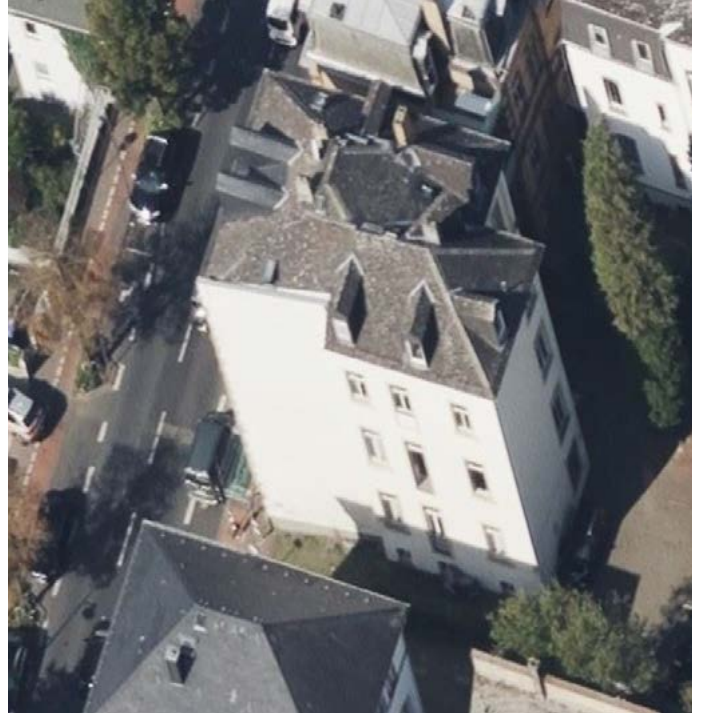
Ansicht aus nord-östlicher Richtung
