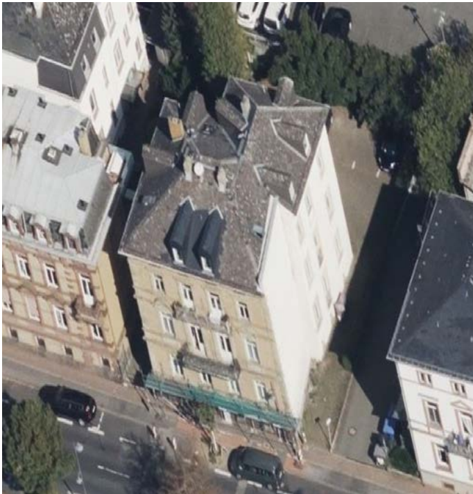
Ansicht aus süd-westlicher Richtung
