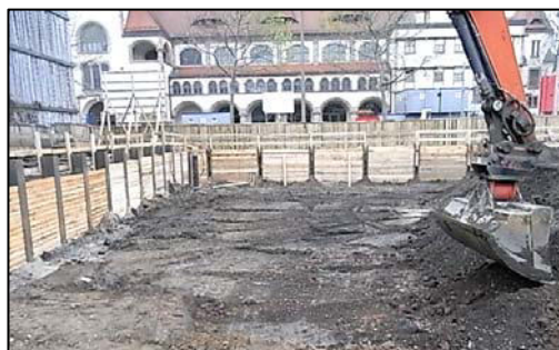
Abb. 4. Schichtenweiser Abtrag, verpflichtend bei baubegleitender KMR
