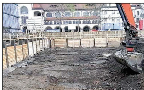
Abb. 4. Schichtenweiser Abtrag, verpflichtend bei baubegleitender KMR
