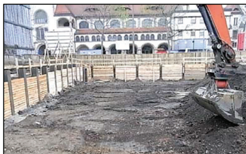
Abb. 4. Schichtenweiser Abtrag, verpflichtend bei baubegleitender KMR
