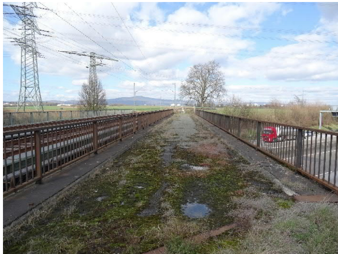
Abb. 16 Querungsstellen der BAB A5 (links: Heerstraße; rechts: Brücke S-Bahn)
